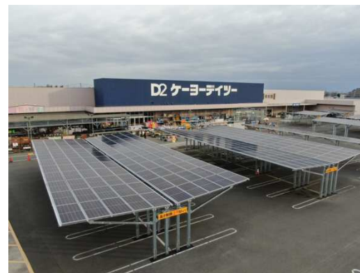
再生可能エネルギー活用
